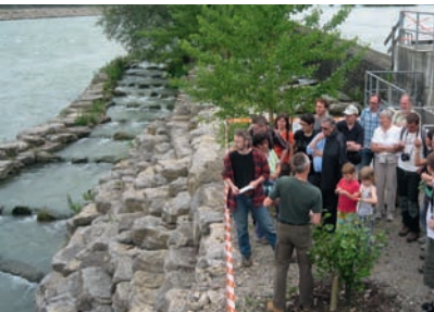
Fischpass beim neuen Kraftwerk Rheinfeldern. Foto: Jochen Ulrich
